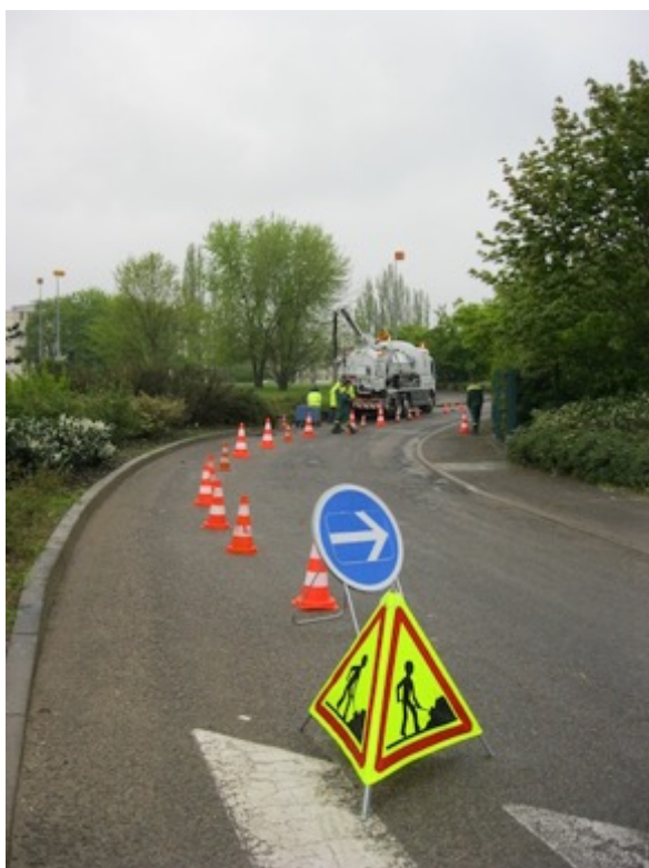
Intervention sur la voie publique
