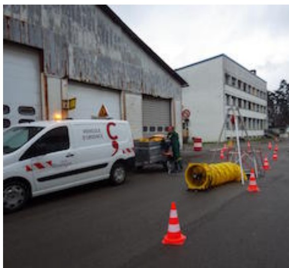
Gestion d'une pollution et mise en place d'une ventilation forcée
