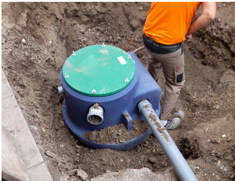
Installation du dégraisseur
