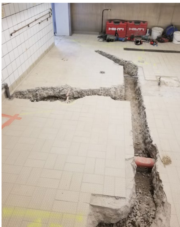
Travaux de restructuration des réseaux internes (séparation des eaux sanitaires des eaux grasses)
