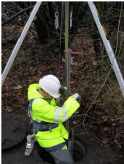
Agent en descente dans le regard pour réaliser le prélèvement
