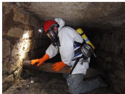
Intervention difficile dans les collecteurs
